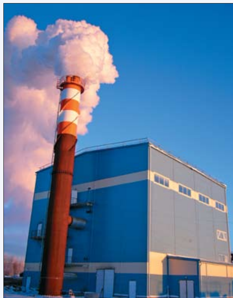
Рис. 4. Котельная установка BioEnergy 2x17 + 9 (г. Онега, Россия)
