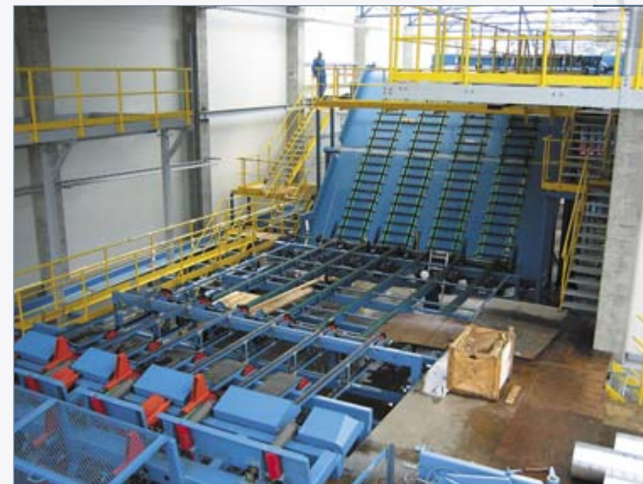
Поставка компании Heinola состояла из 5 технологических линий лесопиления. Инвестиции заказчика являются крупнейшими в Северной Европе. На фотографии показана стадия монтажных работ
