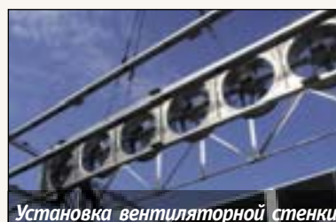
Установка вентиляторной стенки
