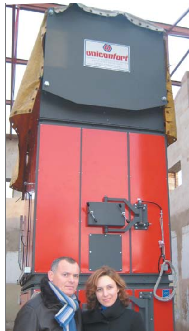
Анатолий Бабичев (ПМЦ) и Елена Шумейко («ЛесПромИнформ») у когла Uniconfort Global/G-300 (мощность – 3,5 МВт, вес – 58 т)
