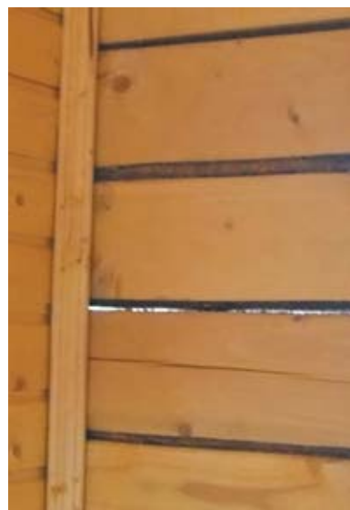
Рис. 7. Щели между брусками с дефектами формы [1]
