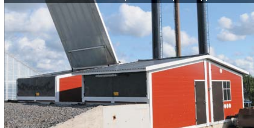
Котельная MeC 500+500 кВт производства MegaKone Oy, 2 бункера для топлива по 39 м³, отапливает теплицы, топливо – щепы и торфяные пеллеты
