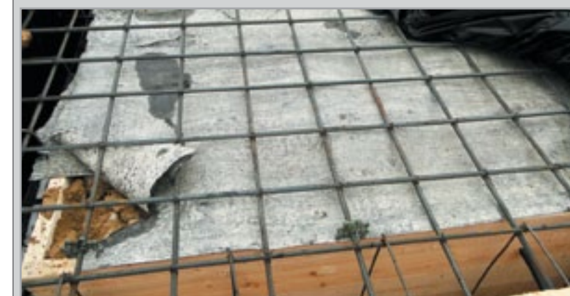
В подсыпке содержатся снег, лед и включения мерзлого грунта
