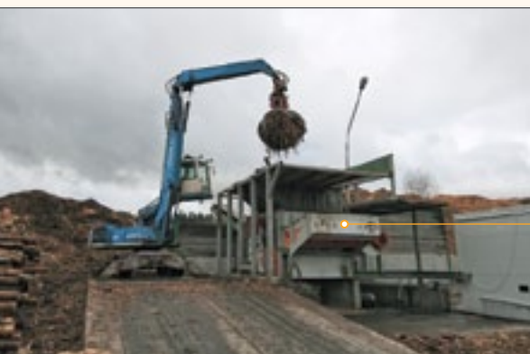
Котельная на биомассе Uniconfort Biotec G250
