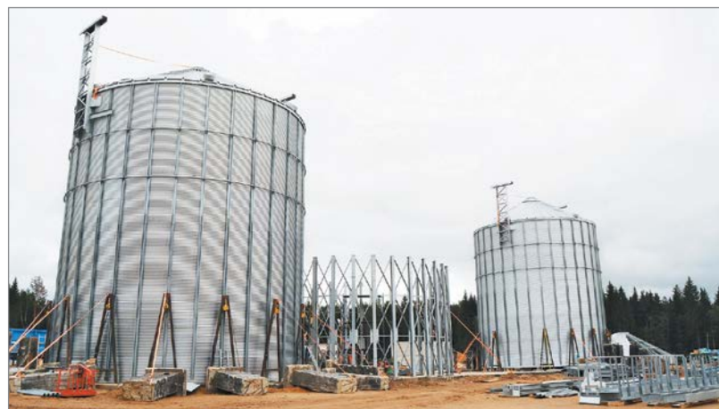
Рис. 13. Строящиеся силосы для пеллет на заводе УЛК в Архангельской области. В этих хранилищах продукция будет накапливаться для отгрузки
