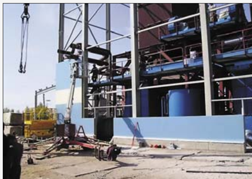
Рис. 4. Монтаж котельной установки BioEnergy 2x17+9 в Онеге
