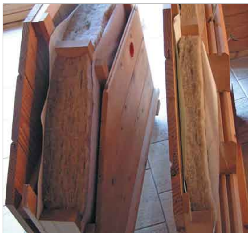
Современные зарубежные примеры решений конструкции стеновых панелей
