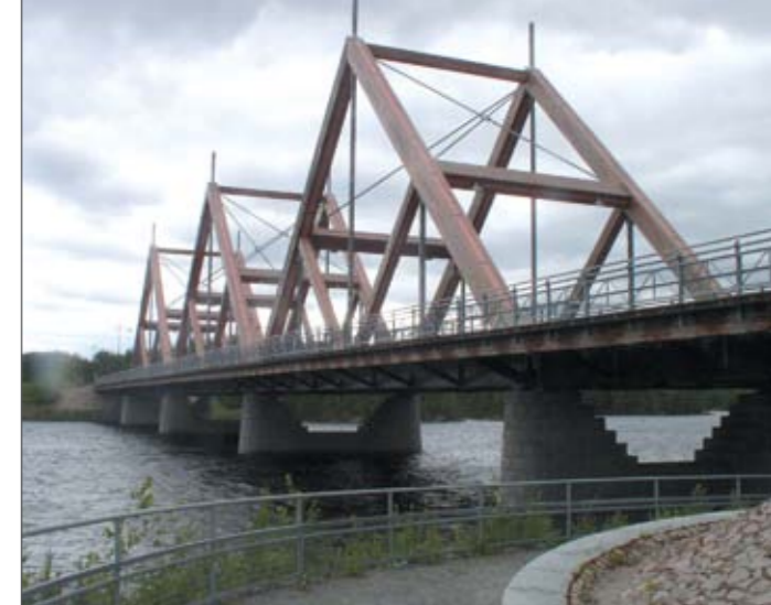
Мост через р. Вихантасалми, Финляндия
