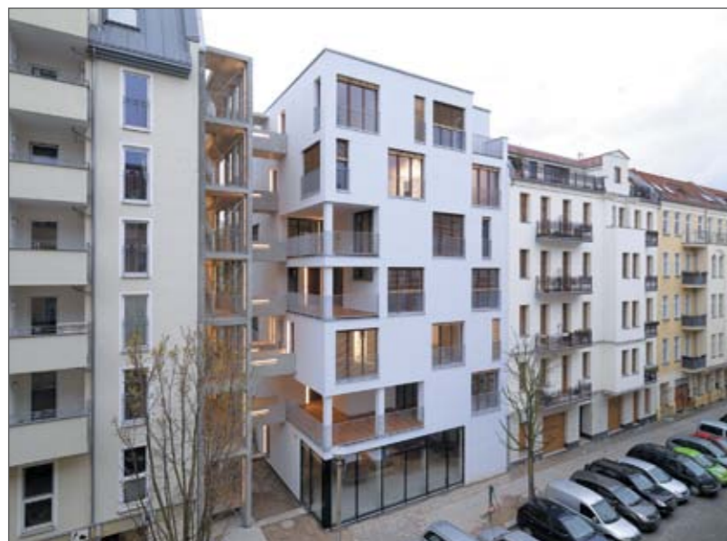
Рис. 3. Семизэтажное деревянное здание в Берлине
