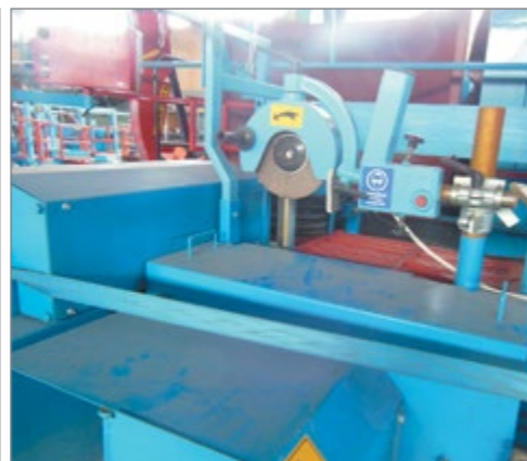
Смонтированное заточное устройство
