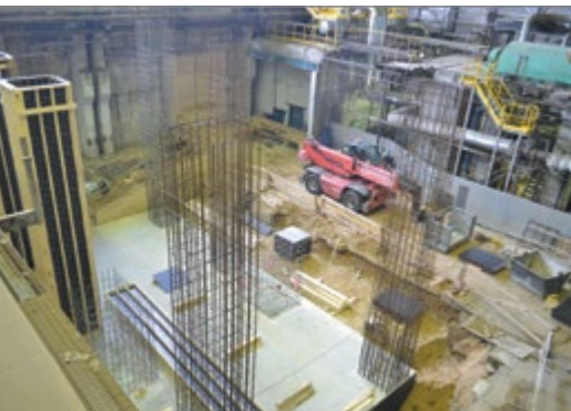
Фундамент для паровой турбины ТЭЦ
