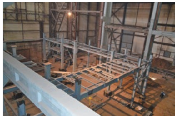
Каркас для будущего корьевого котла ТЭЦ
