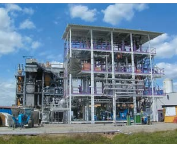
Первый в мире завод по производству газа SNG из древесины в австрийском г. Гюссинг. На переднем плане узел получения метана
