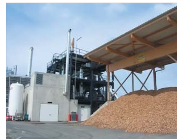
Склад топливной щепы
