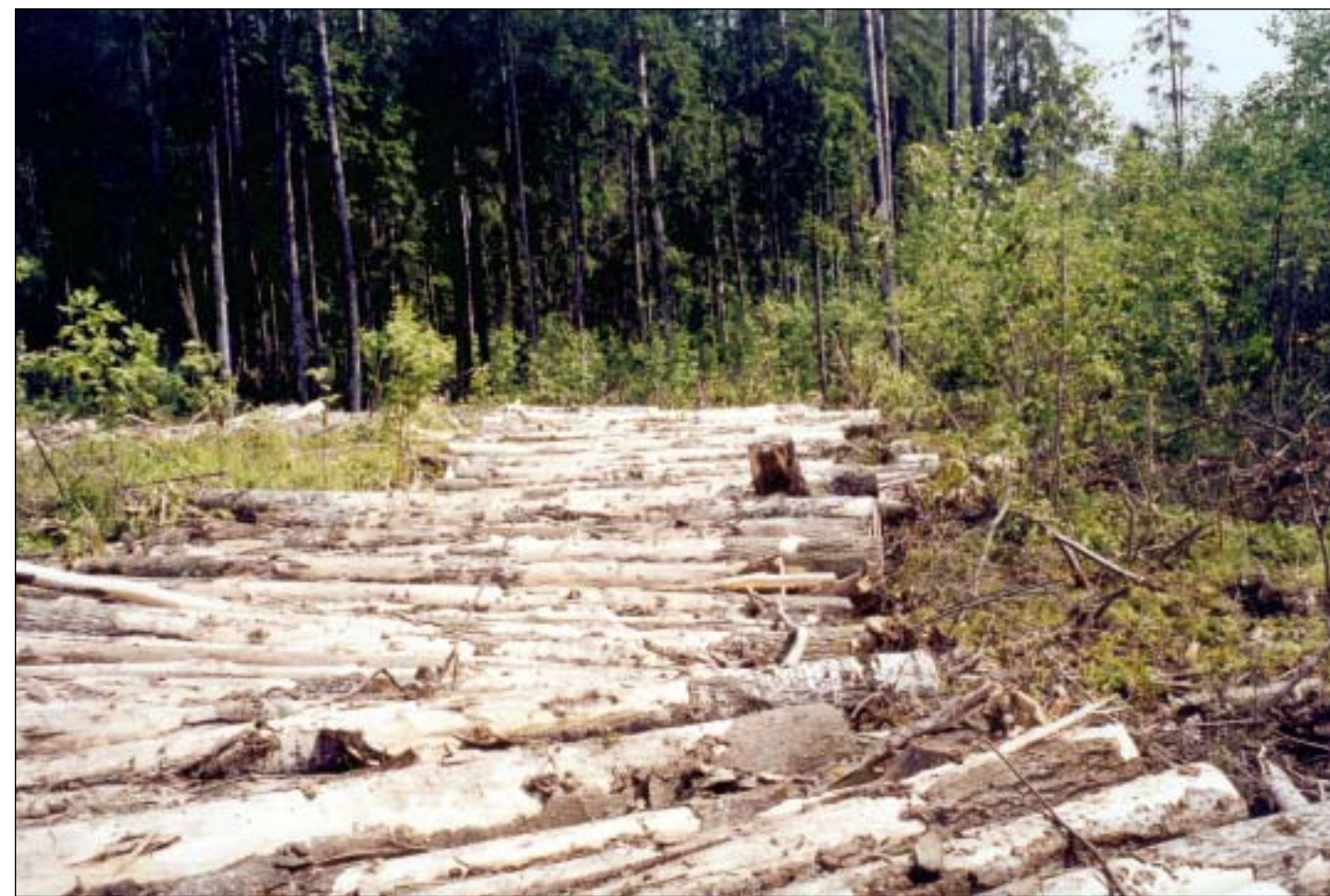
Строительство лесовозной автомобильной дороги
