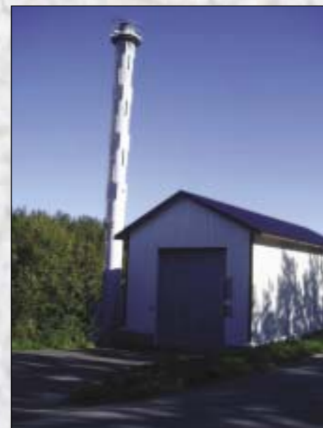
Котельная монастыря Новый Валаам, работающая на древесных гранулах.
