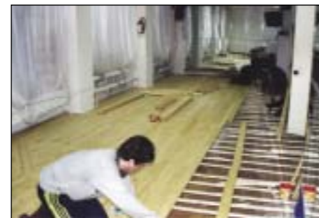
Один сборщик собирает 20–25 м 2 «Экопола» за смену
