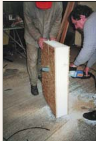
Рис. 6. Работа с плитой OSB на стройке
