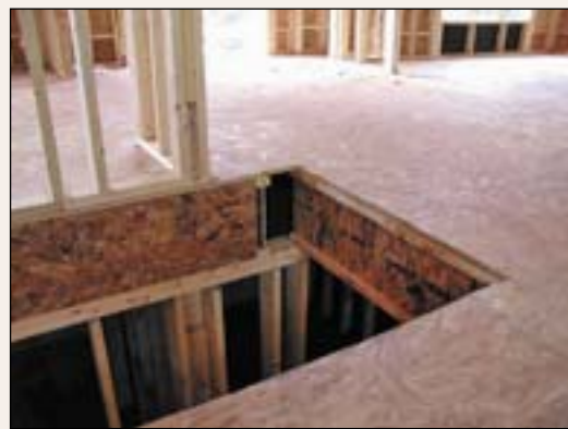
Рис. 5. Использование OSB в межэтажных перекрытиях
