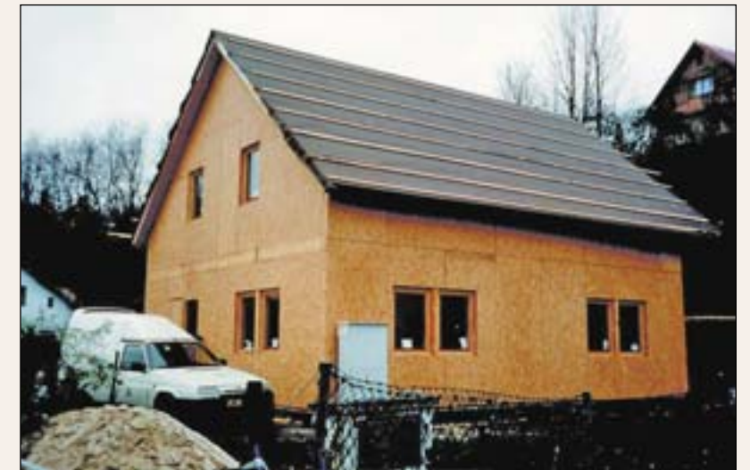
Рис. 3. Использование OSB для обшивки стен каркасного деревянного дома
