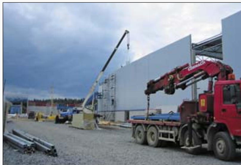
Новый завод «Свирь Тимбер» будет готов к производственному запуску в конце 2005 – начале 2006 года
