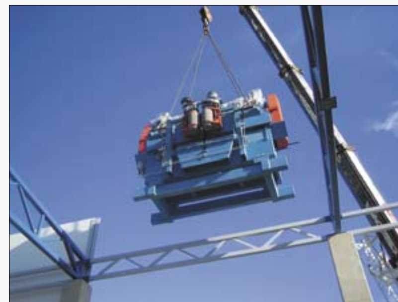
Основные станки лесопильного производства были установлены на фундаментах уже в июле 2004 года
