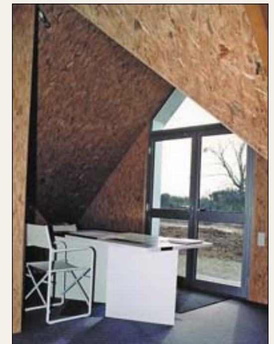
Рис. 4. Использование OSB для внутренней отделки стен
