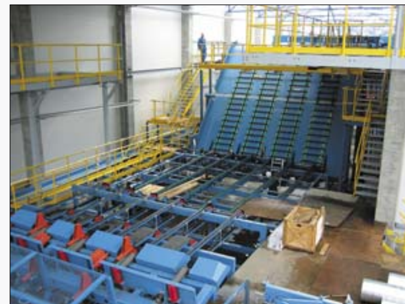
Поставка технологии завода выполняется по расписанию. Первая сотня бревен уже прошла распиловку на новом оборудовании
