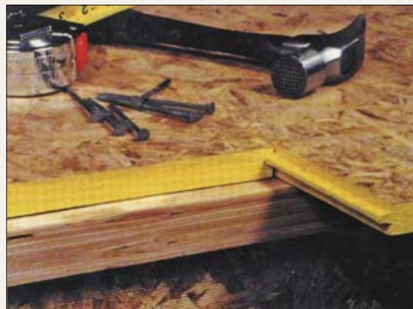
Рис. 13. Соединение плит на шпунт
