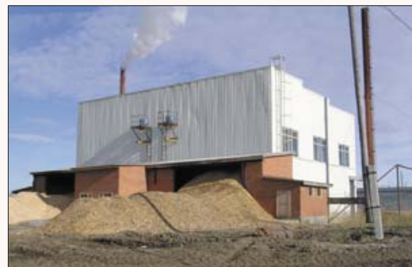
Склад топливной щепы на котельной станции
