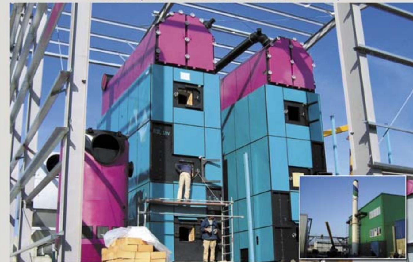
«ЛЕСОБАЛТ» 3x6.000 кВт котельная с гидравлическими механическими колосниковоыми решетками
