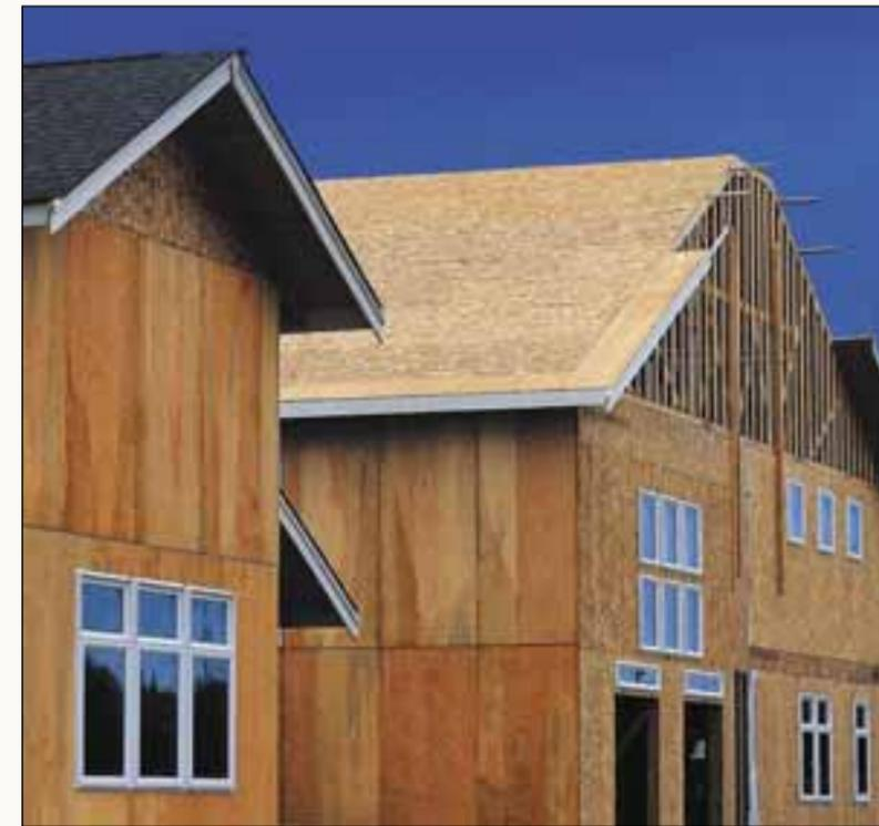
Рис. 7. Использование OSB в кровельных работах
