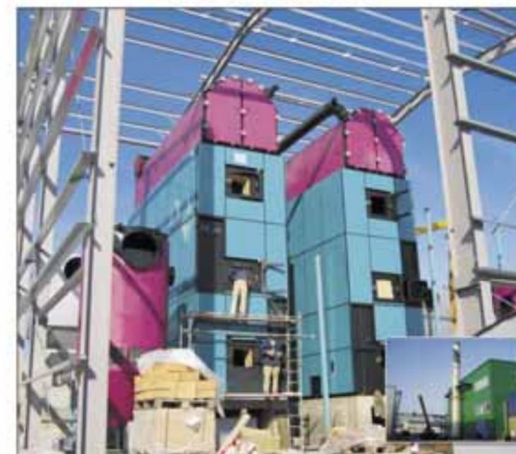
2 x 1.500 кВт топли с гидравлическими механическими колосниковыми решетками
