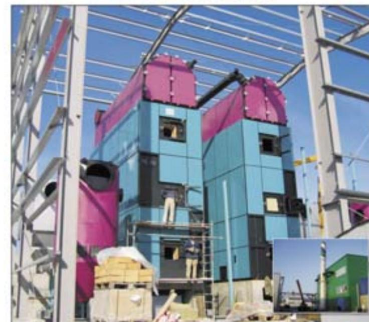
2 x 1.500 кВт топлив с гидравлическими механическими колосниковыми решетками
