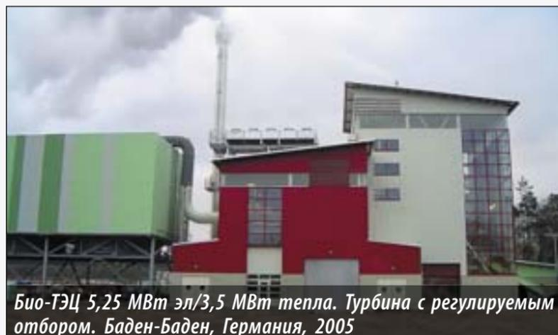
Био-ТЭЦ 5,25 МВт эл/3,5 МВт тепла. Турбина с регулируемым отбором. Баден-Баден, Германия, 2005
