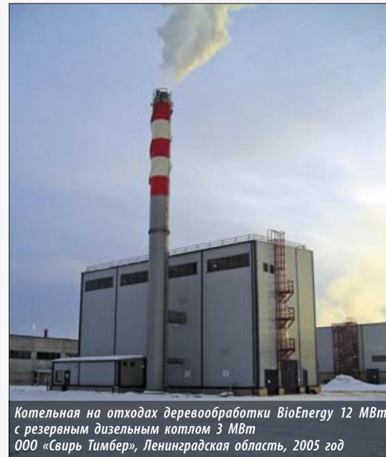
Котельная на отходах деревообработки BioEnergy 12 МВт с резервным дизельным котлом 3 МВт ООО «Свирь Тимбер», Ленинградская область, 2005 год
