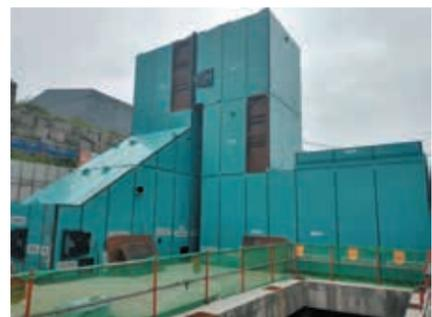
В южнокорейском уезде Йончхон – непосредственно на границе с Северной Кореей – в настоящее время идет строительство паровой котельной установки высокого давления мощностью 21400 кВт. Установка предназначена для сжигания использованной древесины и будет запущена в конце 2021 года.
