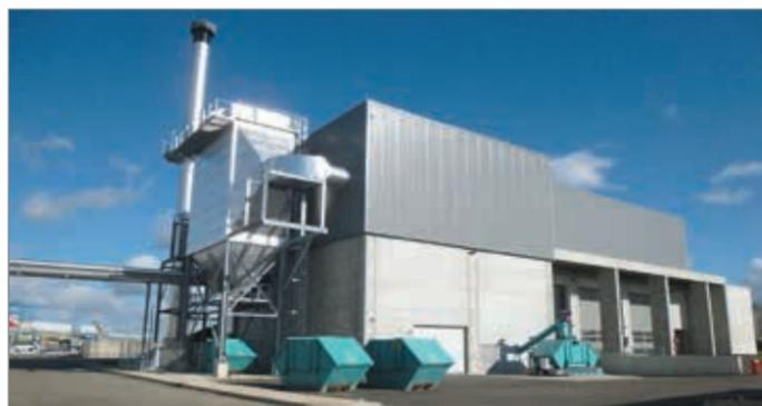
С целью получения энергии при сжигании древесной щепы для компании Airbus была построена паровая котельная установка мощностью 13500 кВт, включая топочное устройство с гидравлической колосниковой решеткой. Установка, расположенная на территории аэропорта в Тулузе, обеспечивает самолетостроение технологическим паром.
