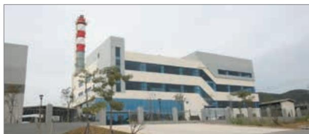
Для китайской компания Jierong в провинции Гуандун предприятие Polytechnik установило когенерационную установку мощностью 34000 кВт, которая вырабатывает посредством турбины 10000 кВт электрической энергии. Данная установка, запущенная в 2021 году, снабжает промышленный парк тепловой и электрической энергией.
