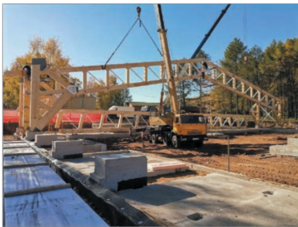
Рис. 10. Выездковый манеж. Монтаж ферм из LVL-бруса (производство и монтаж ООО «СТОД»)
