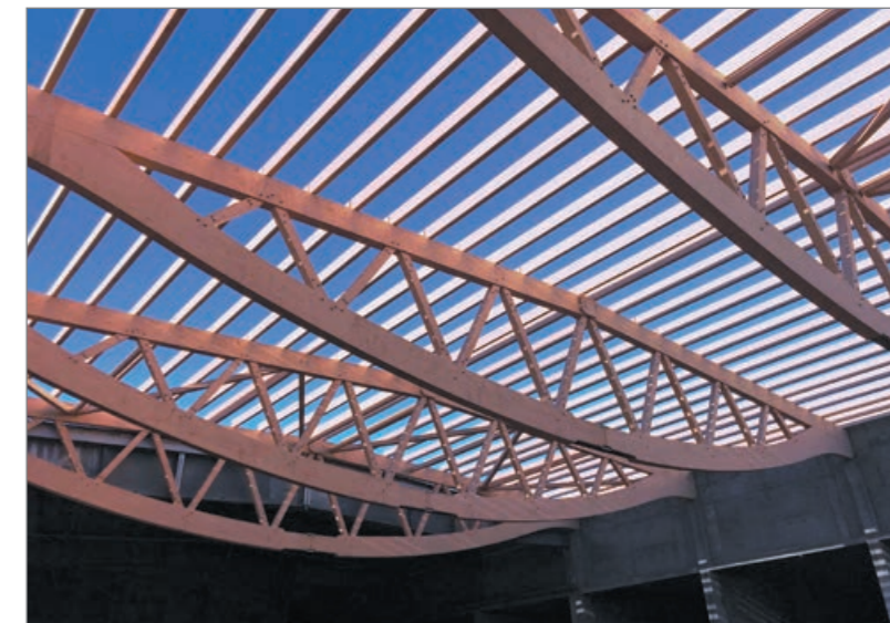
Рис. 12. Здание в составе комплекса по производству шампиньонов (застройщик – ООО «ДСК КМК 2»)
