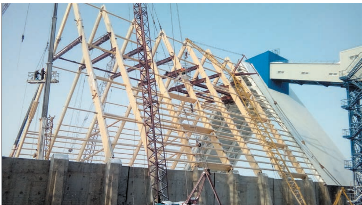
Рис. 8. А-образные рамы склада дробленой руды и готовой продукции пролетом 36 м (Radiuswood)
