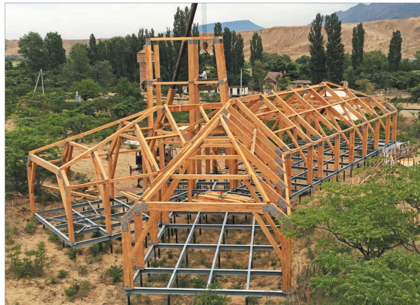
Рис. 17. Строительство из деревянных клееных конструкций визит-центра в заповеднике «Сарыкумские барханы» в Дагестане (Izba de Luxe)
