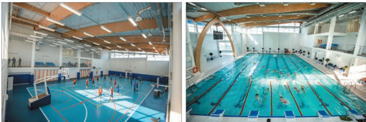
Рис. 3. Линзообразные балки перекрытия типовых ФОК, построенные Radiuswood по программе «Газпром – детям» в Кронштадте (большепролетные конструкции из клееной древесины)
