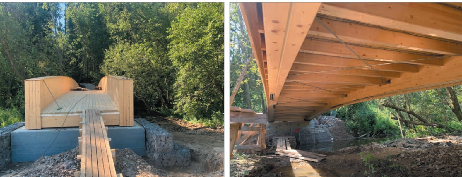
Рис. 15. Использование балок при небольших (до 20 м) пролетах моста в д. Летово Московской области (производство конструкций – корпорация «Русь»)
