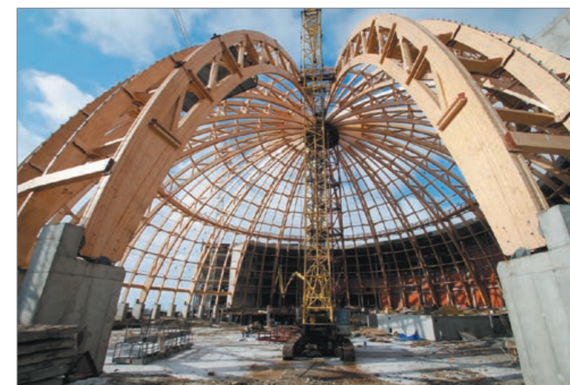
Рис. 13. Уникальный купол аквапарка «Питерлэнд», Санкт-Петербург (конструкции – АО «78 ДОК Н. М.», ООО «Haus-Konzept "Содружество"»)
