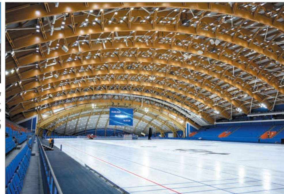
Рис. 5. Сборные трехшарнирные арки стадиона «Енисей» в Красноярске, пролет 99,9 м (производство конструкций – АО «78 ДОК Н. М.», застройщик Radiuswood)
