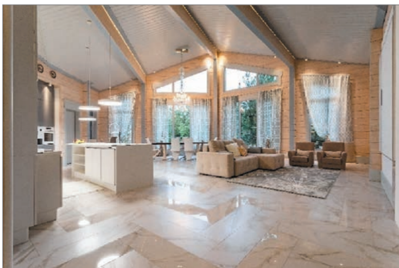
Рис. 4. Однопролетные балки в интерьере жилого пространства индивидуального дома («Русский Запад»)
