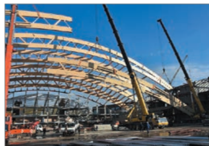
Рис. 5. Сборные трехшарнирные арки стадиона «Енисей» в Красноярске, пролет 99,9 м (производство конструкций – АО «78 ДОК Н. М.», застройщик Radiuswood)
