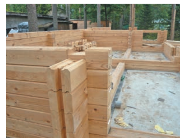
Рис. 4. Возведение дома с несущими конструкциями из деревянного клееного бруса
