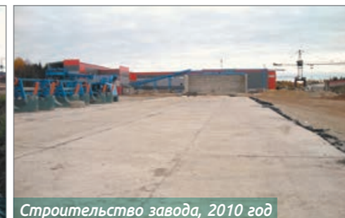
Строительство завода, 2010 год
