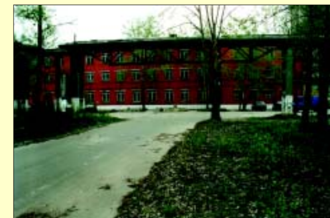
Вид на предприятие со стороны инженерного корпуса
